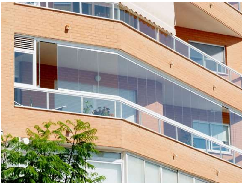
Figuur 6: Voorbeeld dichtmaken balkon van appartementen (bron: http://www.glass-systems.fr )
